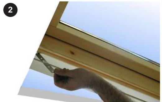
**3)** Controllare che il lato inferiore appoggi perfettamente alla struttura del tetto e con l'aiuto di una livella verificare che sia perfettamente orizzontale.
